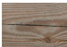
Spannungsrisse durch die Holz Trocknung
