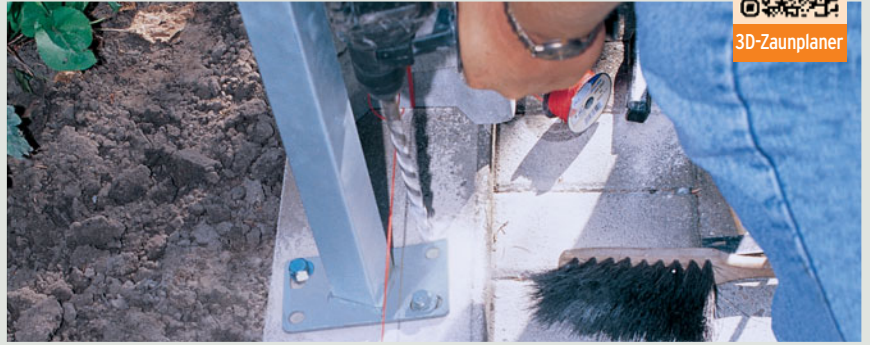
oder mit Pfostenträger aufschrauben.
