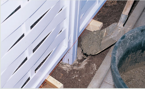
Zaunpfosten direkt ins Erdreich einbetonieren...
