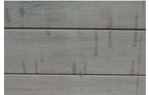
Fleckenbildung durch von Regen angelöste Partikel
