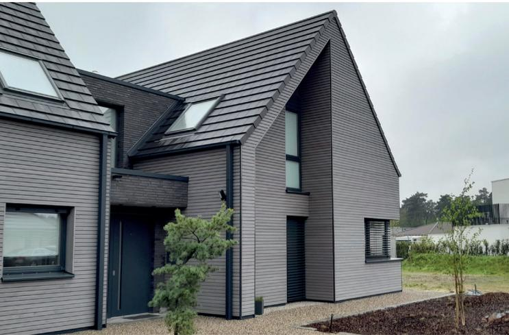
Mit einer pigmentierten Lasur kann die Vergrauung verzögert werden und eine gleichmäßigere Optik bei zurückliegenden Fassadenflächen erzielt werden.
