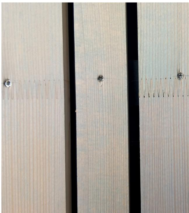
Je nach Hersteller kann die Keilzinkung deutlich sichtbar sein.
