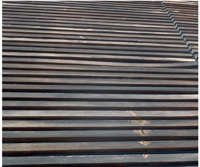
Zu große Abstände bei der Unterkonstruktion oder zu hohe Feuchtigkeit führt bei drehwüchsigen Hölzern zu Ausfällen.
