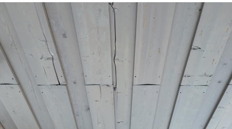
Die fehlerhafte Befestigung der Boden- und Deckelbretter mit nur 1 Schraube führt zu Spannungsrissen.
