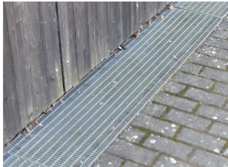
Mit ca. 200 mm breiten Gitterrosten kann eine nicht ganz optimale Sonderlösung erzielt werden.
