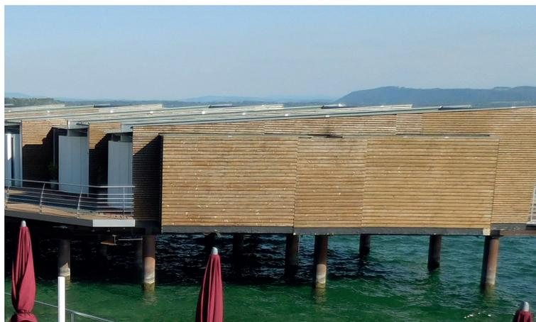
Bei diesem Objekt ist die farbig behandelte Holzfassade auf der Wasserseite nur mit sehr großem Aufwand regelmäßig zu kontrollieren bzw. zu warten und Instand zu setzen. Alternativ sollten pflegeleichtere Produkte eingesetzt werden.
