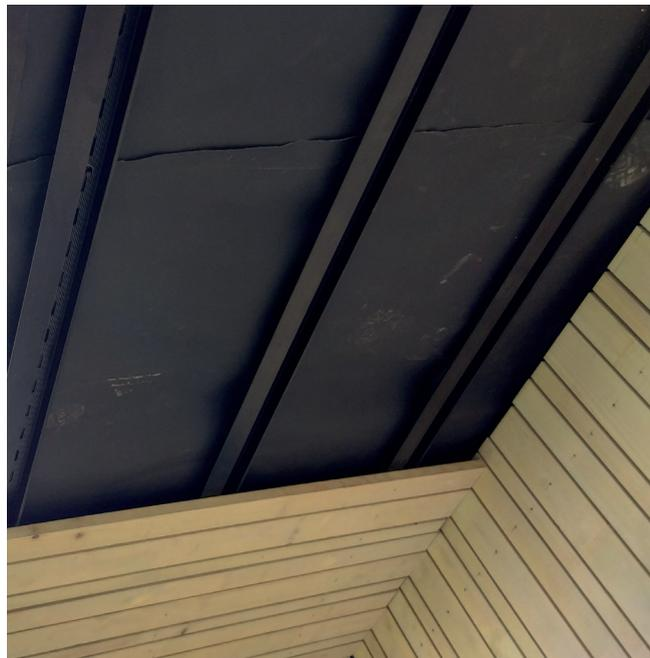
Für senkrechte offene Fassadenprofile werden entsprechende Aluminiumsysteme angeboten, die je nach Produkt schwarz beschichtet sind und ähnlich wie schwarz behandelte Holzunterkonstruktionen nicht mehr so auffallen.
