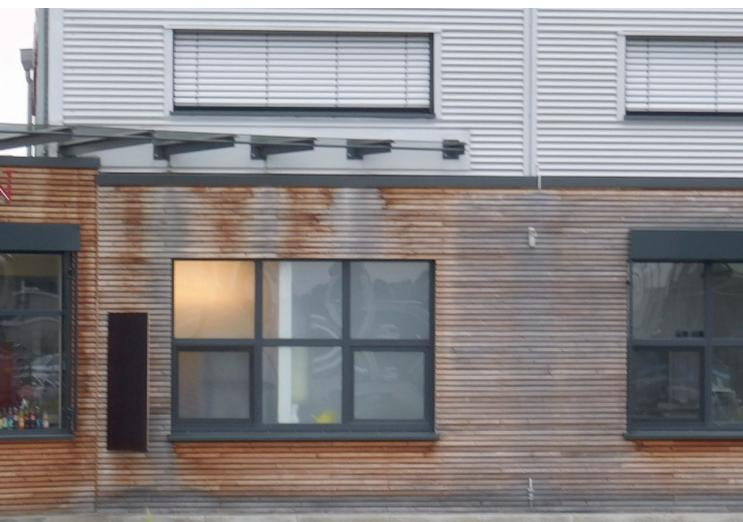
Das Glasvordach wurde nicht optimal ausgeführt, und Wasser läuft an den Trägern auf die Holzfassade. Das Holz wäscht aus, da UV-Licht nicht vom Glas abgehalten wird.
