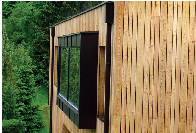
Die senkrechte offene Fassadenbekleidung wurde in den Fachregeln 01 – Außenwandbekleidungen aus Holz, 2. Auflage; ausgeschlossen und gilt als Sonderkonstruktion.
