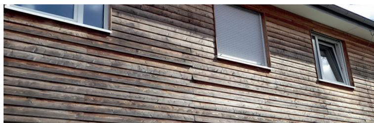
Bei zu hoher Holzfeuchte springen Fassadenprofile bei niedriger Holzfeuchte aus der Nut.
