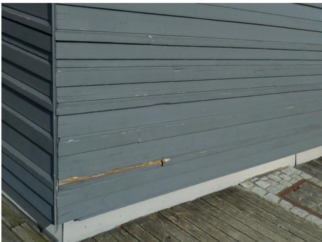
Der geringe Spritzwasserabstand hat zu einer hohen Feuchtigkeit unter der Beschichtung geführt und nach 11 Jahren einen Totalausfall bei den unteren Profilen verursacht.
