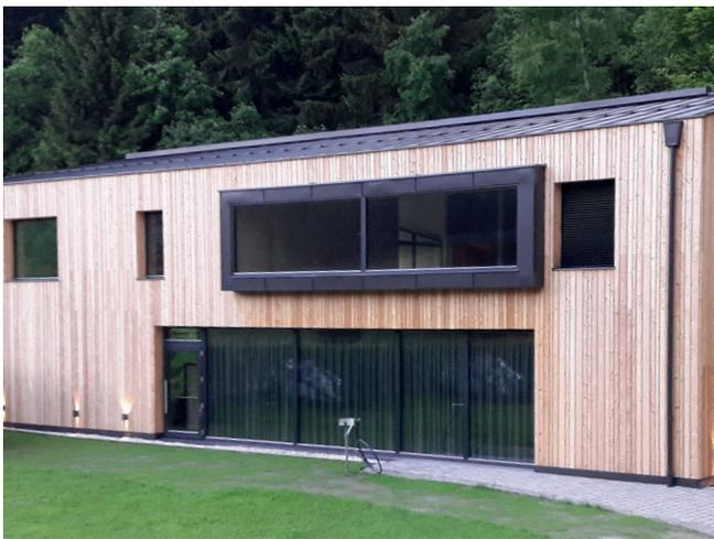
Die senkrechte offene Fassadenverkleidung wurde in der Fachregel 01 ausgeschlossen. Zusätzliche Maßnahmen sind erforderlich.
