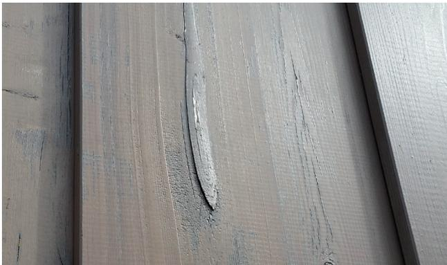
Durch die Bewitterung kann es bei einer Massivholz-Fassade zu einer sogenannten Ringschäle kommen.
