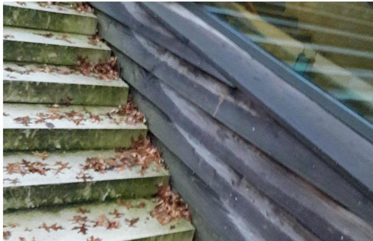
Zu geringe Spritzwasserabstände und Ablagerungen von Schutz oder Laub, führen zu einem vorzeitigen Ausfall der Konstruktion.
