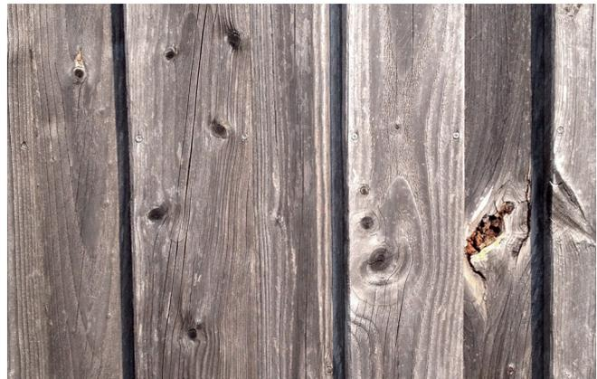
Bei der Montage von Fassadenbekleidungen muss evtl. eine Nachsortierung erfolgen oder müssen z. B. Tabakäste ausgekappt werden.
