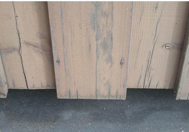
Die Schnittkanten der farbig behandelten Hölzer wurden bei der Montage nicht an den Schnittkanten nachbehandelt und führten deshalb zu stärkeren Endrissen, höherer Feuchtigkeit und zu Verfärbungen unter der Farbbehandlung.
