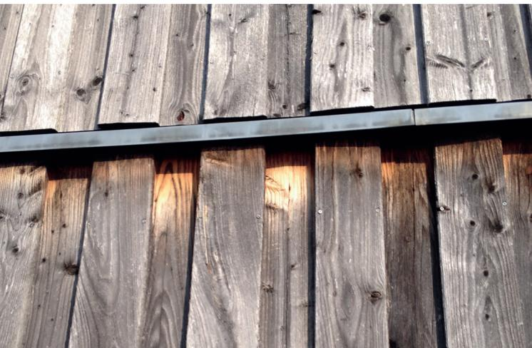
Bei senkrechten und diagonalen Fassadenbekleidungen dürfen i.d.R. keine stumpfen Längsstöße ausgeführt werden.
