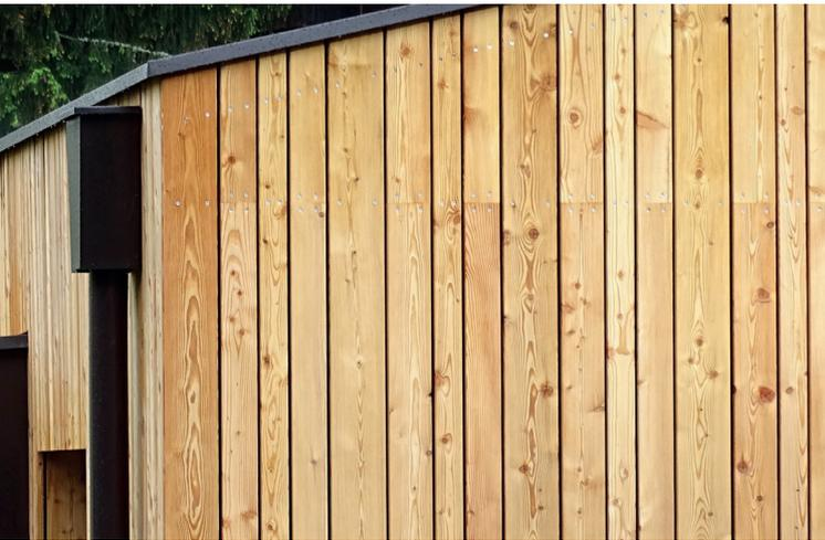
Bei senkrechten und diagonalen Fassadenverkleidungen dürfen i.d.R. keine stumpfen Längsstöße ausgeführt werden.
