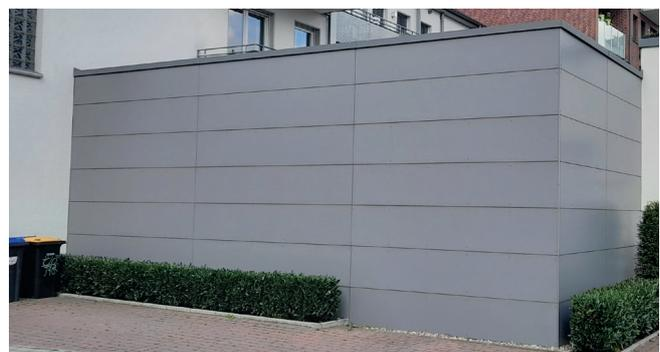
Mit der Vorfertigung kann eine hochwertige Optik durch ein gleichmäßiges Fugen- und Schraubbild und bessere Kantenausbildung erzielt werden.
