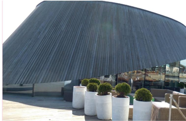
Für fast astfreie Fassaden wird das Produkt Kebony Clear verwendet, denn Fassade bekommt eine gleichmäßige graue Patina.
