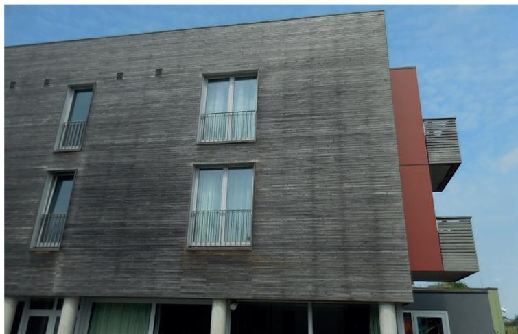
Wenn standortbedingt mit einer Aufwechtlung der Trag- und Grundlattung zu rechnen ist, muss eine Holzart verwendet werden, die min. in der Gebrauchsklasse GK 3.1 eingesetzt werden darf.
