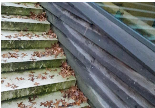
Laubablagerungen führen zu einer höheren Holzfeuchtigkeit und können die Hinterlüftung der Fassade behindern. Wenn gleichzeitig der Spritzwasserabstand fehlerhaft ausgeführt wird, ist mit einer viel kürzeren Nutzungsdauer zu rechnen.
