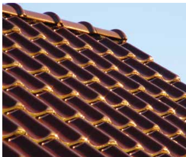
Eine Ziegeleindeckung für das Dach. Joda® bereitet alles vor, inkl. Dachsparren, Latten etc.
