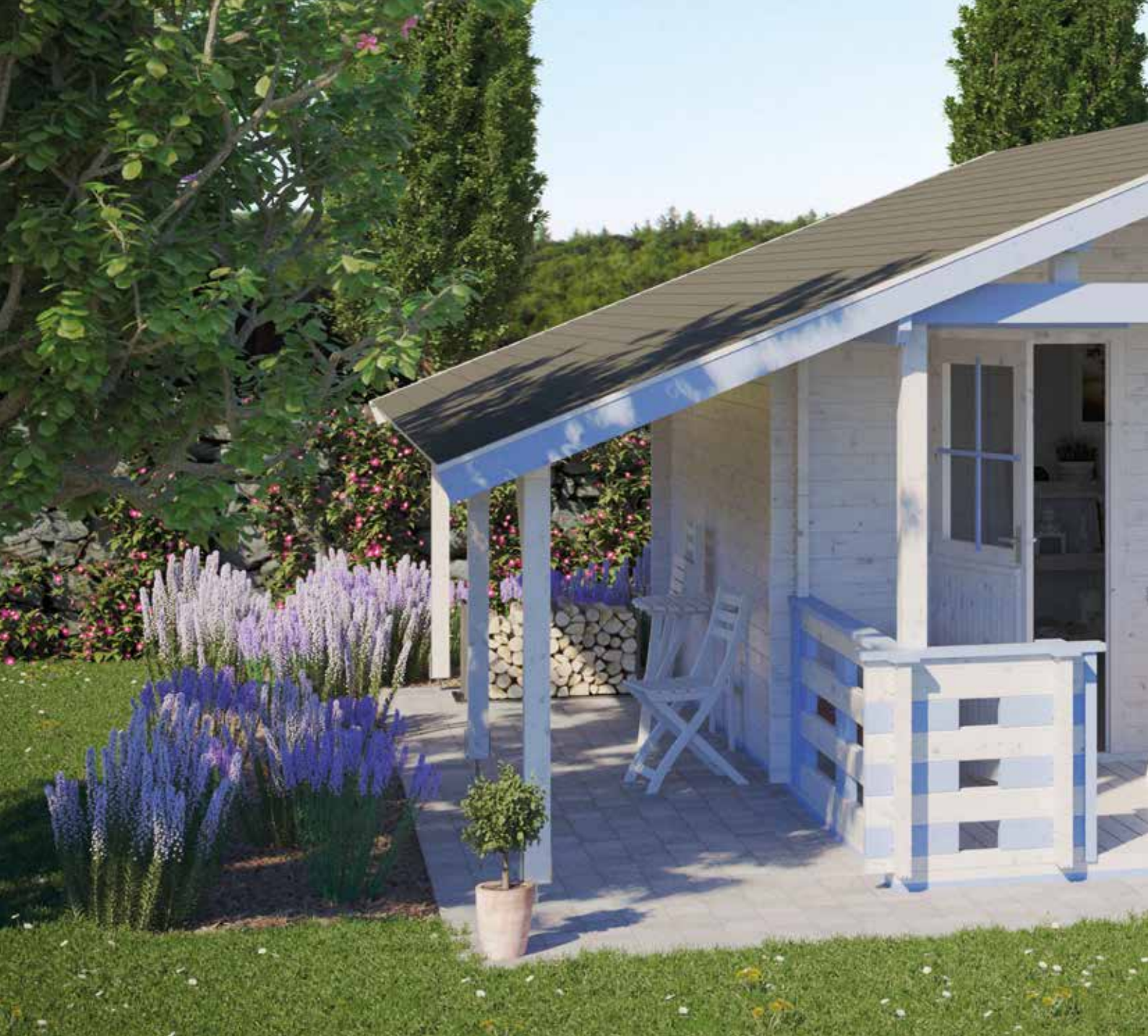
Terrasse aus imprägnierten Glattkantenbrettern ca. 23 x 95 mm auf imprägnierter Unterkonstruktion.
