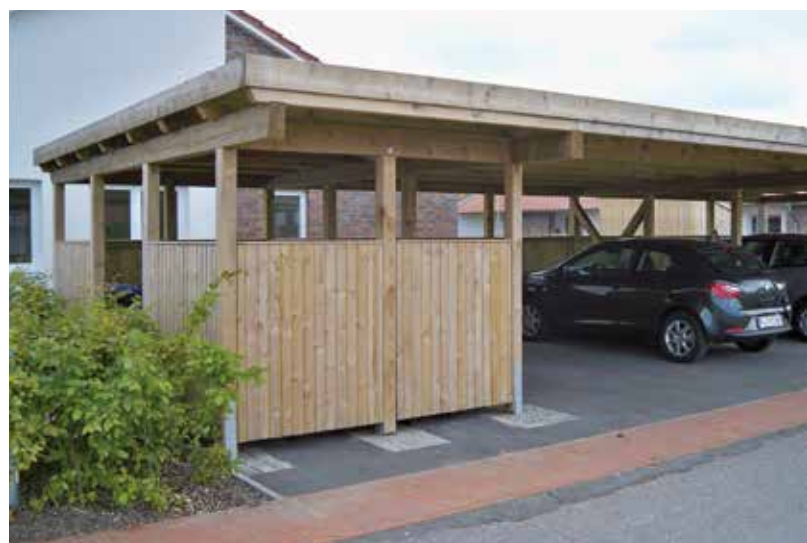
Integrierte Müllplatz-Lösung unter klassischer Stellplatz-Anlage
