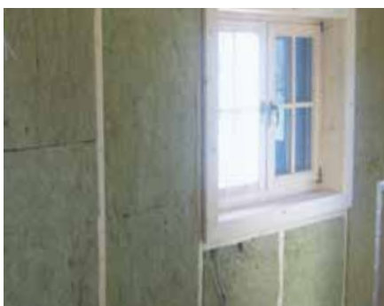
„Winterfest-Option“: doppelschalige Außenwand mit innenliegender Dämmung
