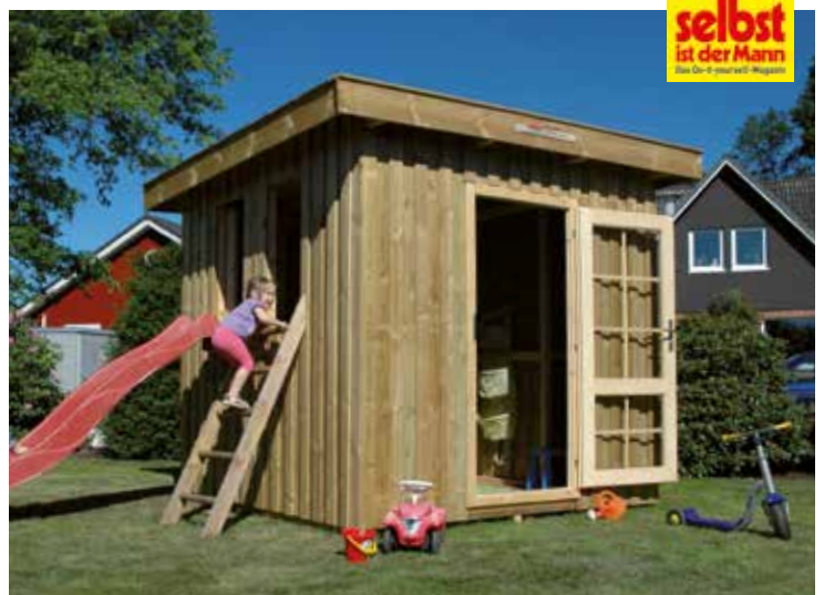
Als Kinder-Spielhaus mit Kletterwand, Rutsche etc. Wände mit KDI-Konstruktionsholz verkleidet
