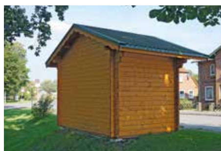
Rückansicht des oben gezeigten Bushäuschens (bauseits farbbehandelt)
