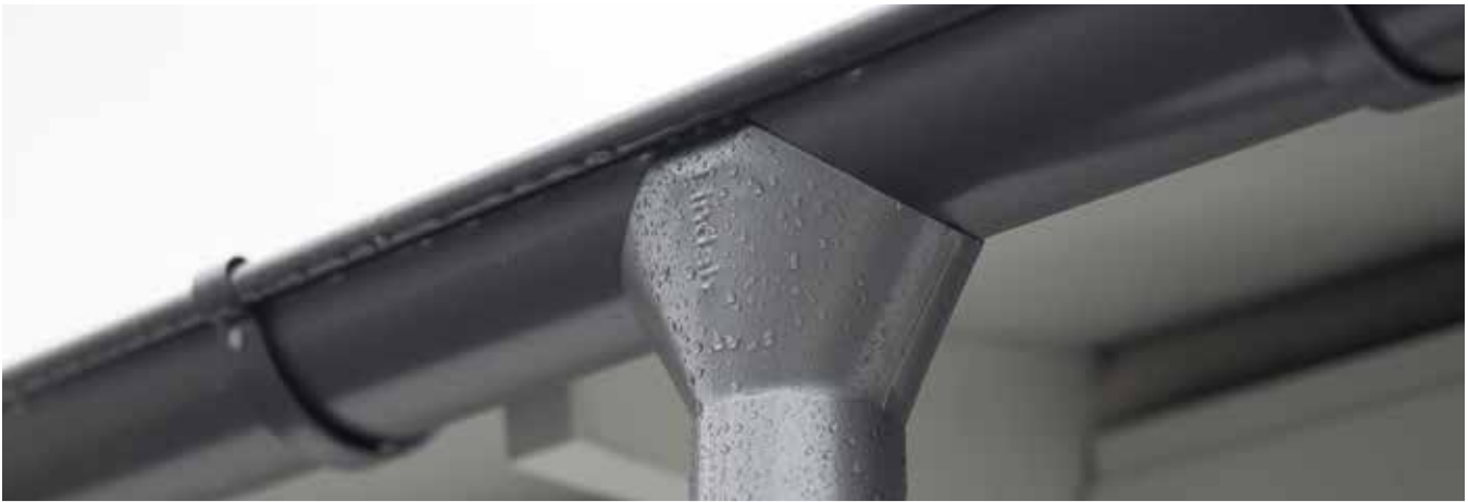
Dachrinnen vollenden den Eindruck
