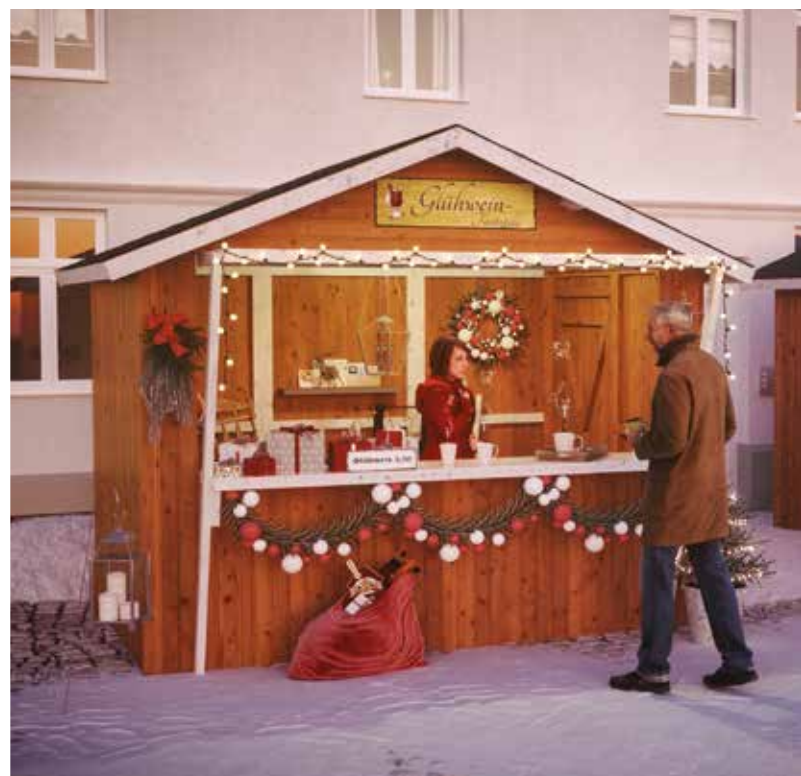
Der „Kiosk“ – hier bauseits farbbehandelt – macht zu jeder Jahreszeit eine gute Figur
