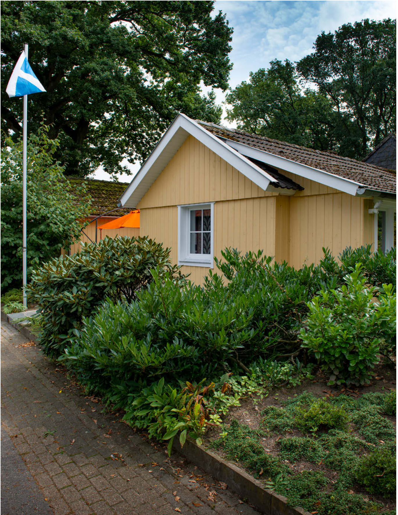
Boden-Deckelschalung, Fichte, endbehandelt mit Osmo Landhausfarbe 2204 Elfenbein
