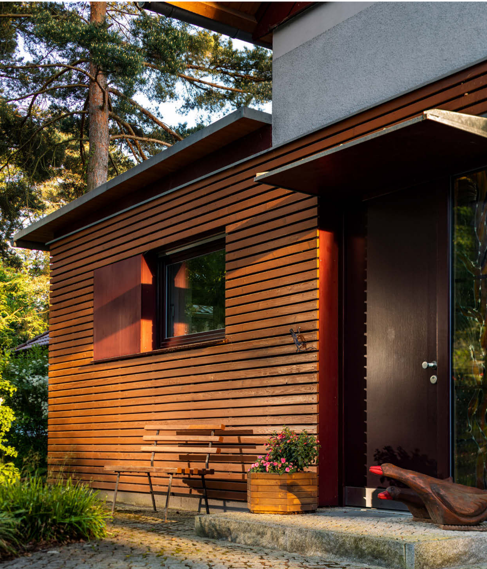
Rautenleiste sib. Lärche, endbehandelt mit Osmo Holzschutz Öl-Lasur 728 Zeder
