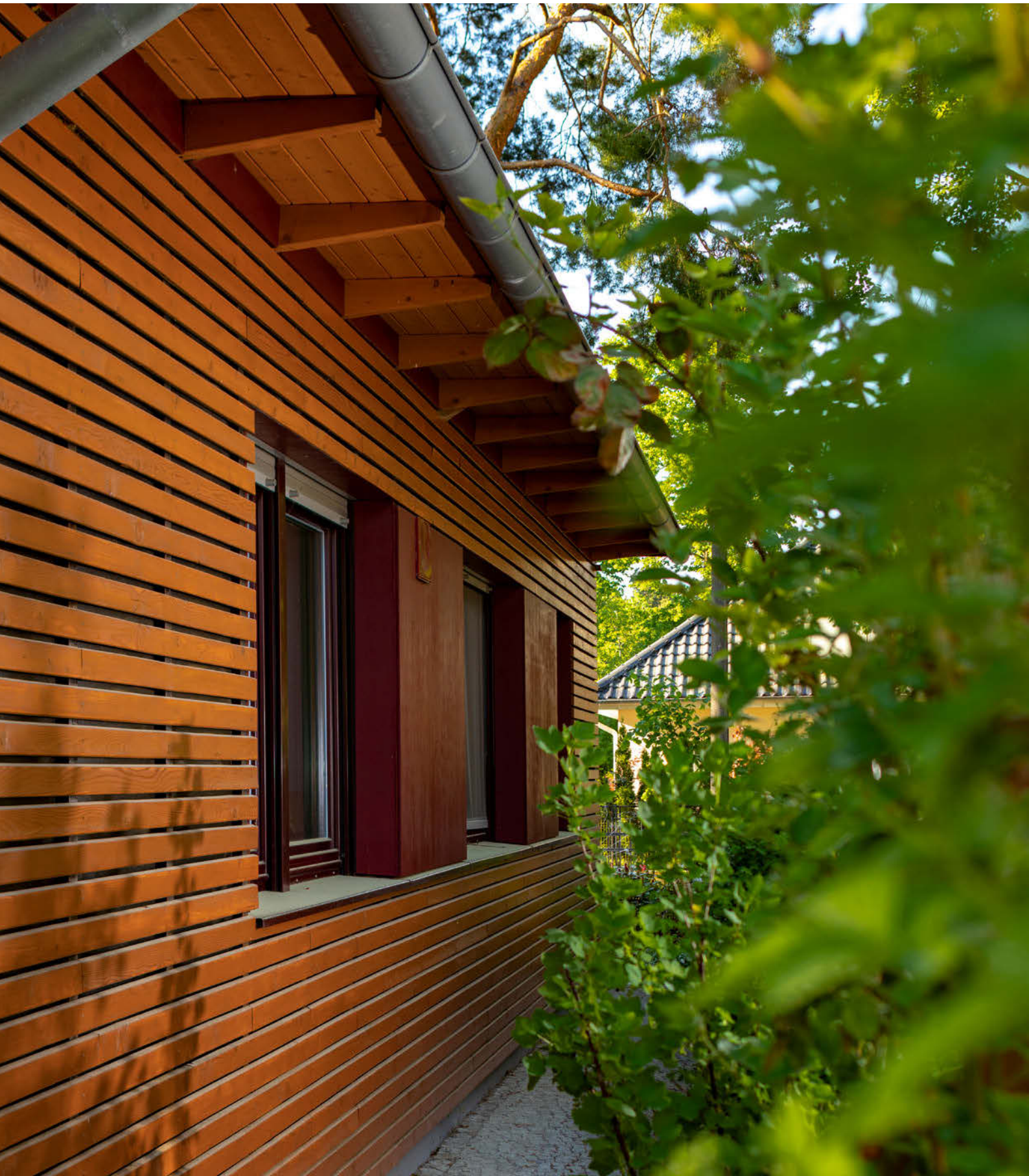
Rautenleisten sib. Lärche, endbehandelt mit Osmo Holzschutz Öl-Lasur 728 Zeder
