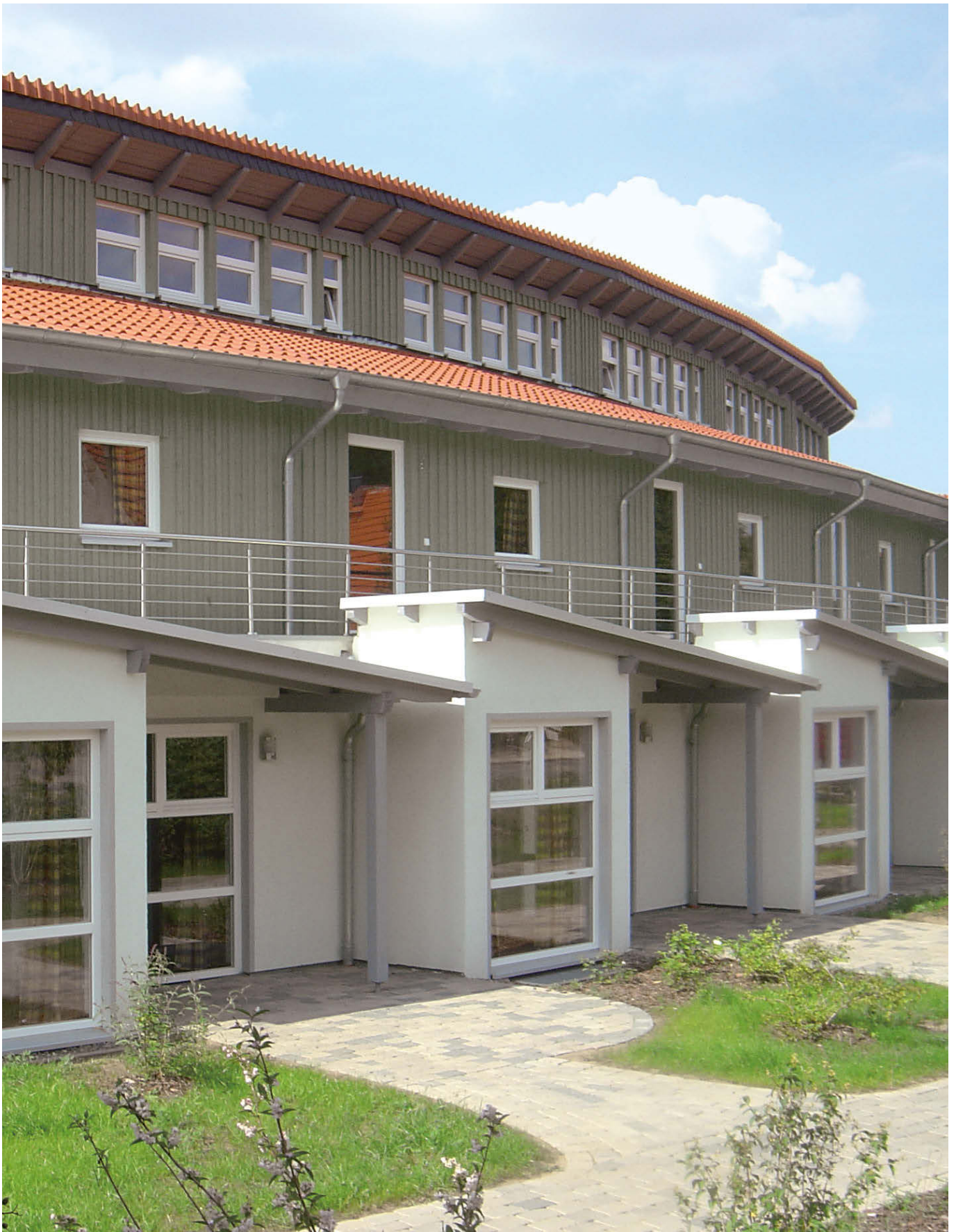
Boden-Deckelschalung, Fichte, endbehandelt mit Osmo Landhausfarbe RAL 7002 Olivgrau Hinweis: Durch Umwelteinflüsse kann es – insbesondere in schattigen Lagen und in der Nähe von Gewässern oder Bäumen – zu oberflächlichem Algen-/ Pilzbefall kommen. Dieser Befall ist nicht auf Materialfehler, sondern auf Sporenflug zurückzuführen.
