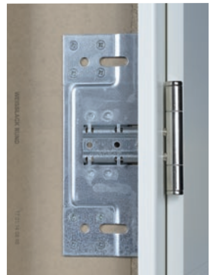
verstärkte Bandtasche ST108 zusätzliche Verstärkung der Tragfähigkeit
